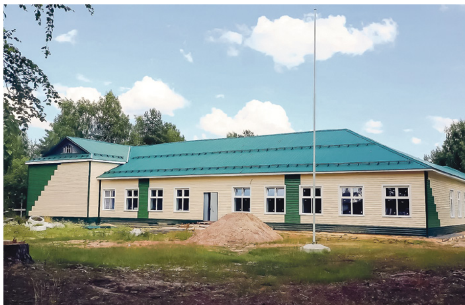
В Хетовской школе ремонт идёт к завершению
