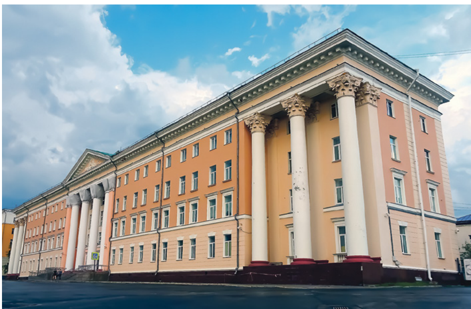
Административное здание на месте инженерного корпуса. Фото Татьяны Барашковой
