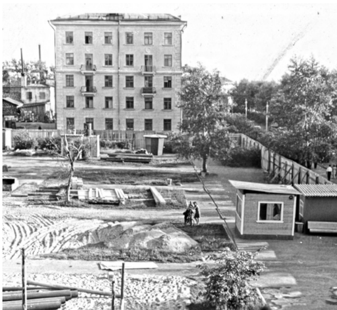
Строительная площадка перед началом работ
