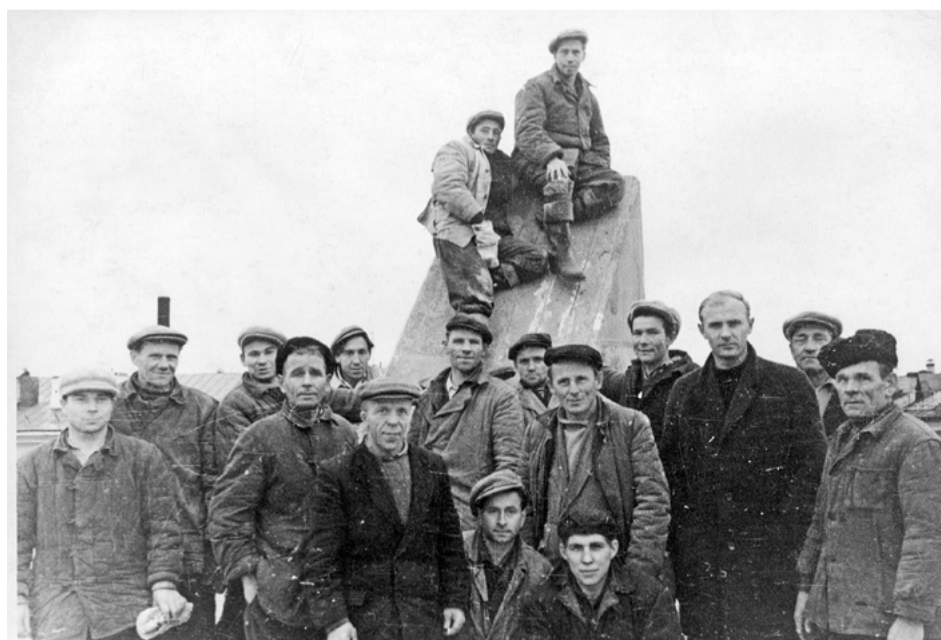
Строители на вершине стелы после начала демонтажа опалубки
