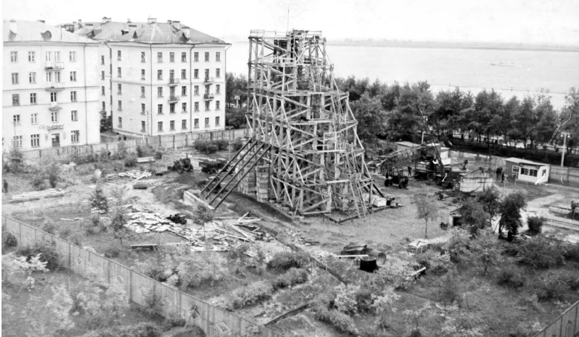
Панорама стройки монумента перед началом бетонирования
