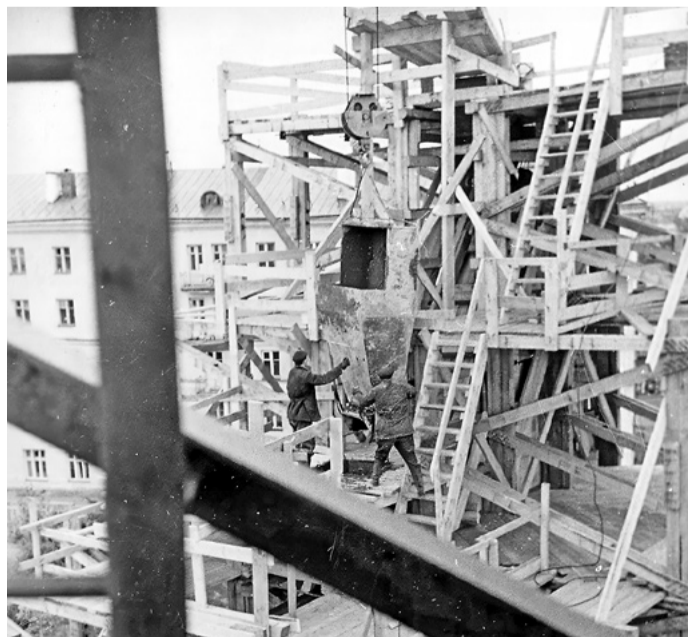
Рабочие принимают бетон из бадьи-туфельки
