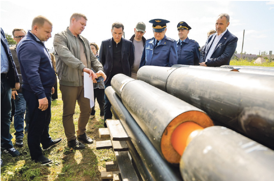
В Мезени идёт строительство тепловых сетей
