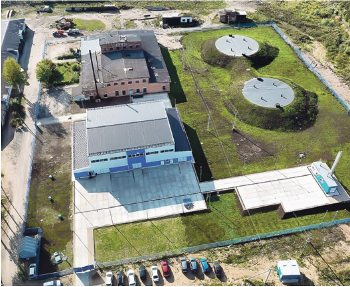
Водопроводные очистные сооружения в Вельском районе после реконструкции по федеральному проекту «Чистая вода». Сентябрь 2024 года
