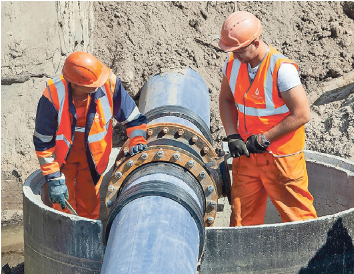
Самый масштабный за последние десятилетия коммунальный проект Архангельска – строительство 5 км кольцевого водовода. Он позволит проводить ремонт на ветхих участках «тысячника» без отключения потребителей
