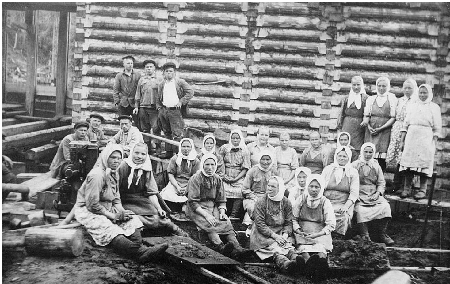
Строители колхозной ГЭС
