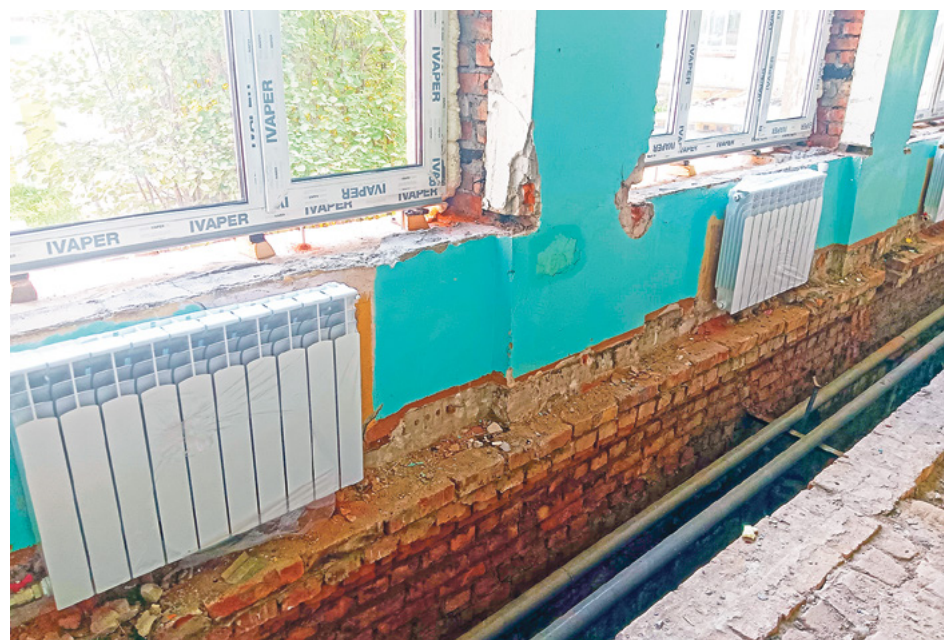
В школе уже установлено отопление
