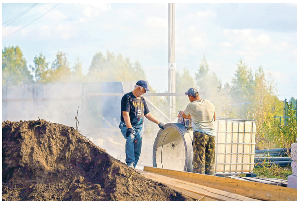
В Емецке завершается строительство многоквартирного дома для переселения граждан из аварийного жилья
