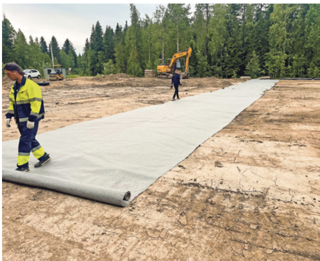
Идут работы по устройству прослойки из геосинтетического материала перед отсыпкой подстилающего песчаного слоя
