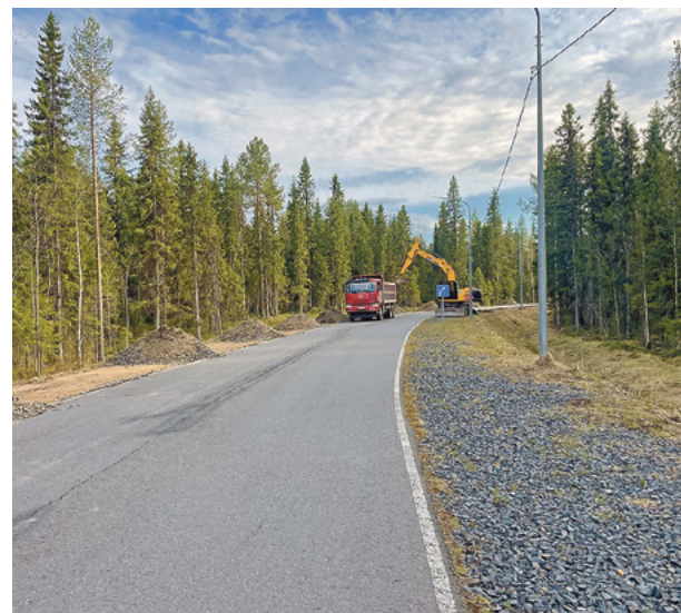
Производится разборка существующих обочин из щебня
