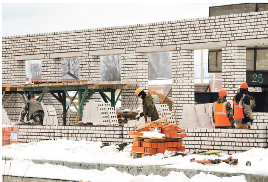
В Каргополе продолжается строительство школы на 320 мест
