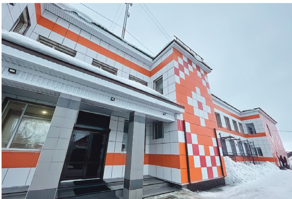
Капитальный ремонт фасадов культурного центра в Мезени планируют завершить в марте
