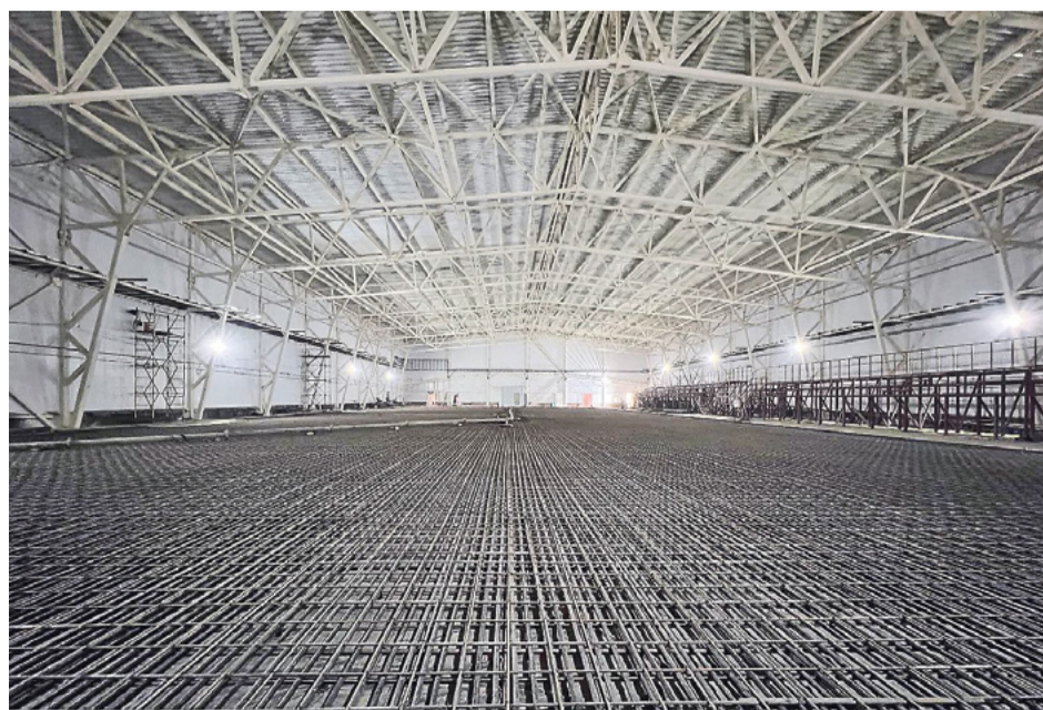
На северодвинском стадионе «Север» продолжается возведение крытой ледовой арены
