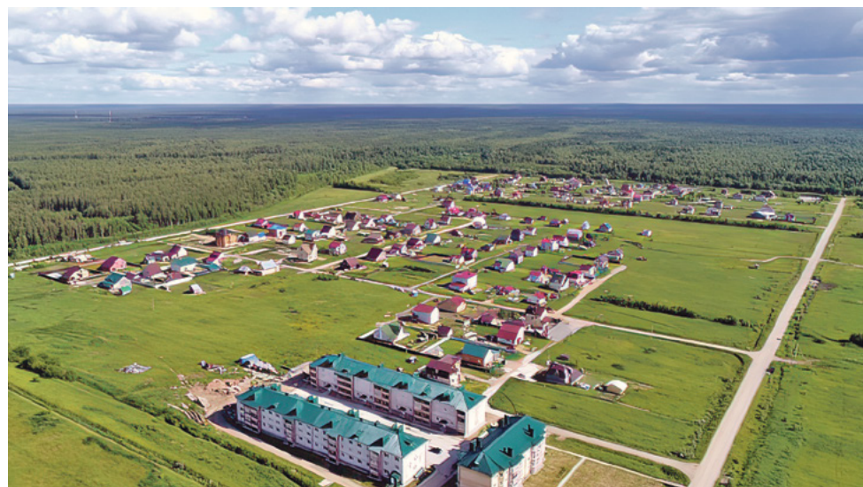
За 13 лет существования Зелёный-1 не оснащён качественными инженерными коммуникациями
