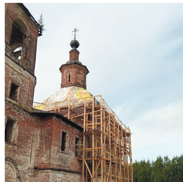
Купол храма укрыли баннерами – теперь ему не страшны ни дождь, ни снег
