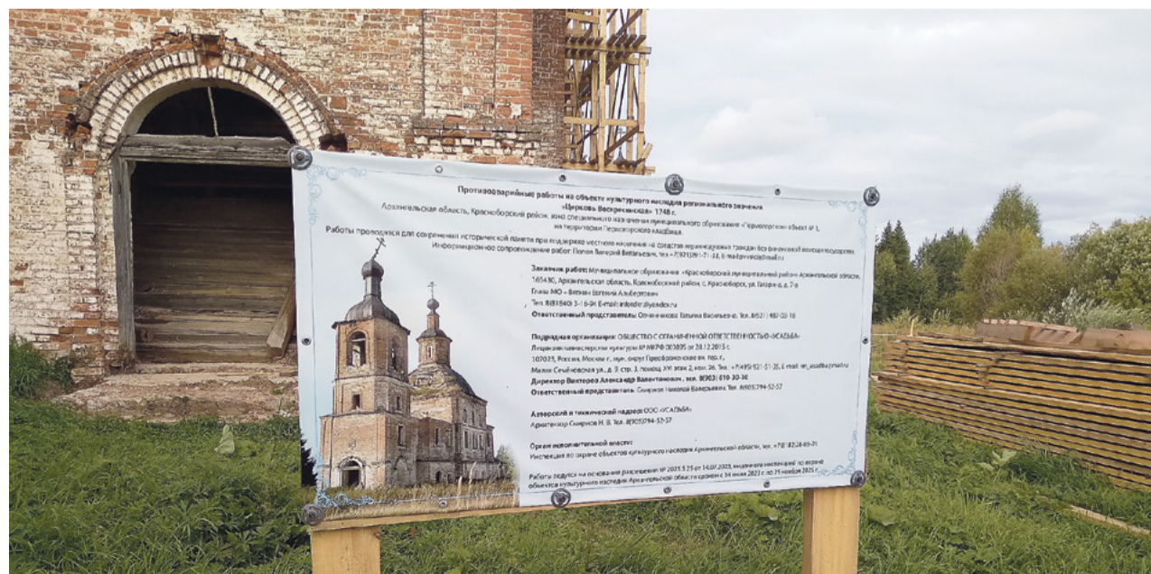
Информационный щит рассказывает о проведении противоаварийных работ
