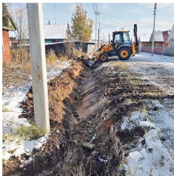
Прокладывается водоотводная канава на улице Седова – так поощряется инициативность жителей
